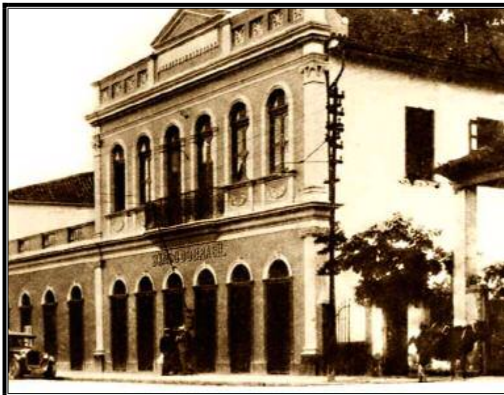
Figura 27: Fachada do Banco do Brasil, década de 30 (CD Zona da Mata)
