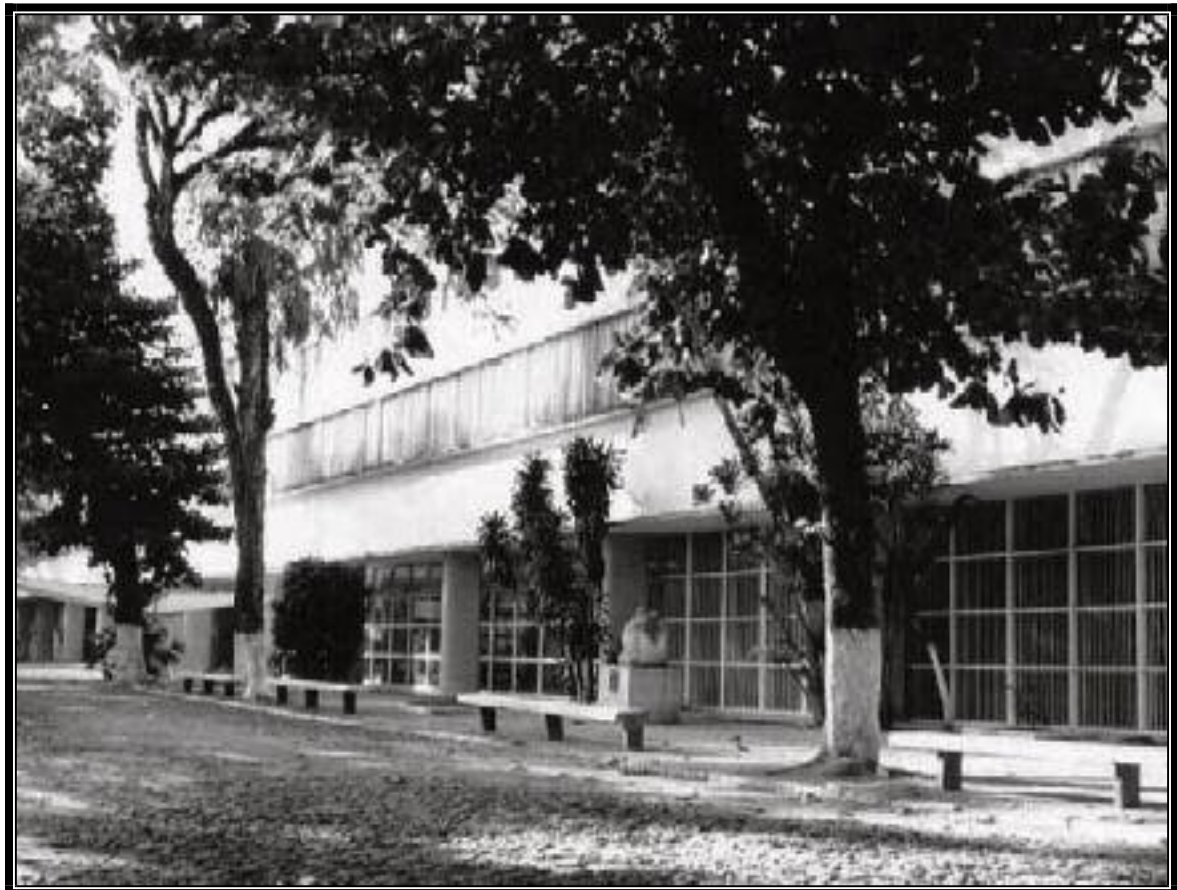
Figura 45: Fachada parcial do Colégio Cataguases, obra de Niemeyer, considerado o marco da transformação de Cataguases, com detalhe da escultura “O Pensador” de Jan Zach (Foto do Autor)
