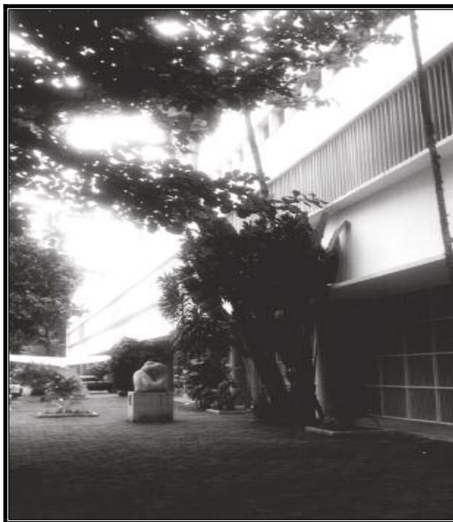
Figura 16: Parcial do Colégio Cataguases, com escultura de Jan Zach (Foto do Autor)
