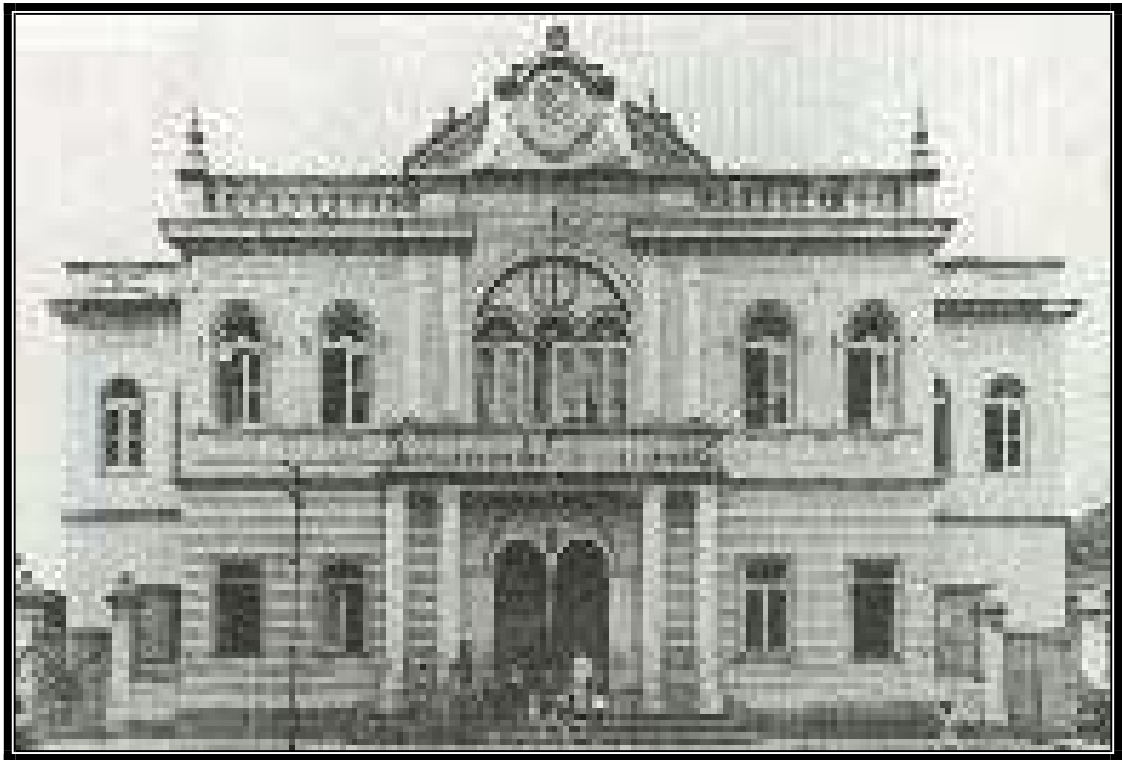
Figura 25: Fachada do Teatro Recreio, demolido em 1947 (Arquivo Público Municipal)
