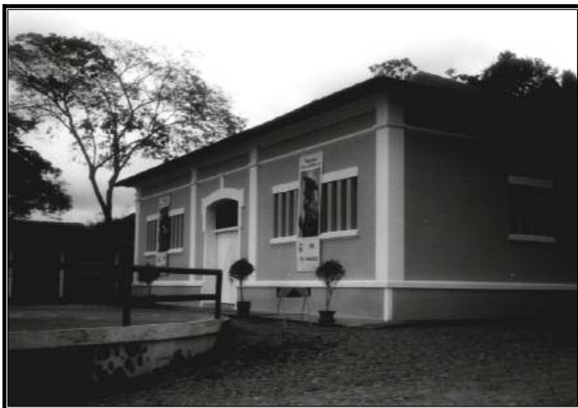
Figura 46: Prédio da antiga casa de máquinas de tratamento de água “Caixa D’Água”, transformada recentemente no centro cultural “Centro de Tradições Mineiras” (Foto do Autor)
