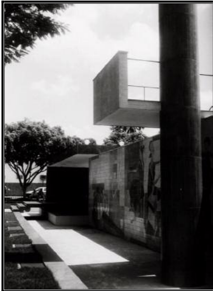
Figura 35: Detalhe de monumento às fiandeiras, de Portinari (Foto do Autor)
