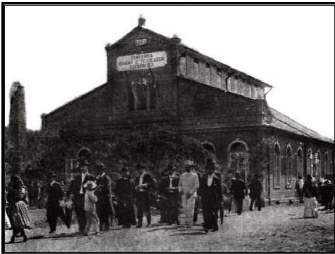
Figura 09: Cia. Fiação e Tecelagem Cataguases em 1905 (Fonte: CD Zona da Mata)
