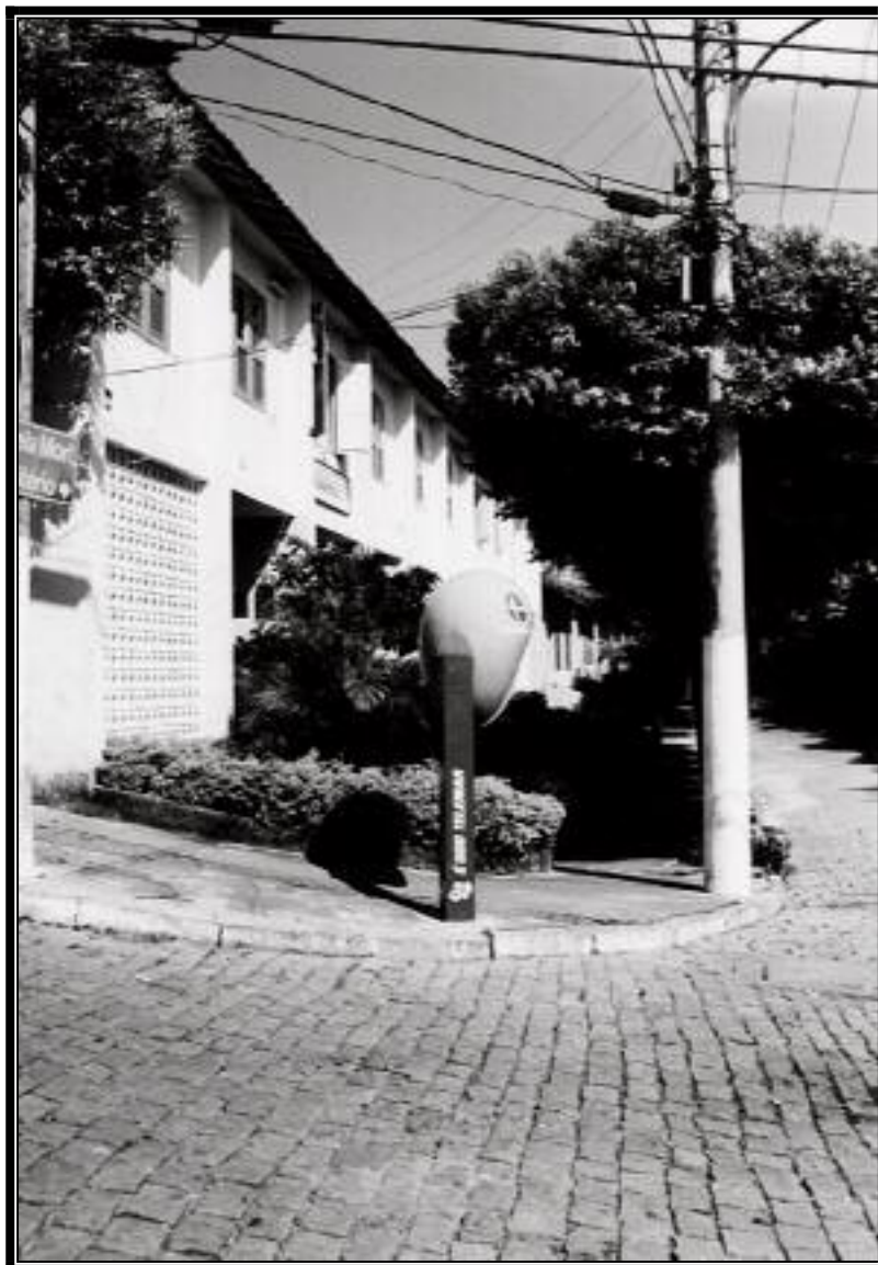
Figura 41: Casario categorizado do Bairro Jardim, segundo bairro operário construído junto à Companhia Industrial Cataguases (Foto do Autor)
